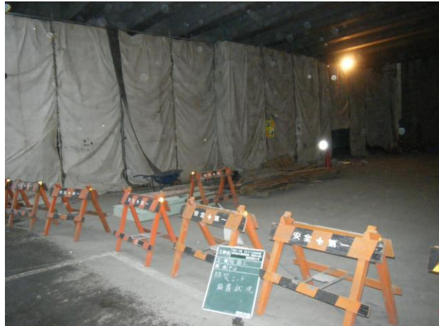
防災シート設置状況
