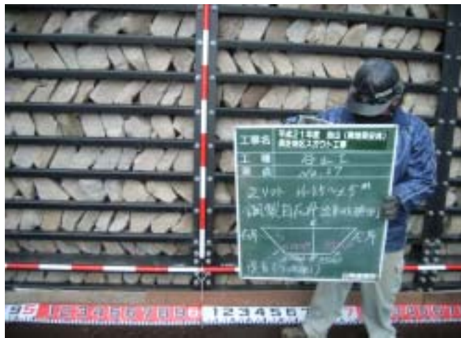
詰石(矢羽積)完了全景
