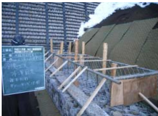
フトンカゴ施工状況
