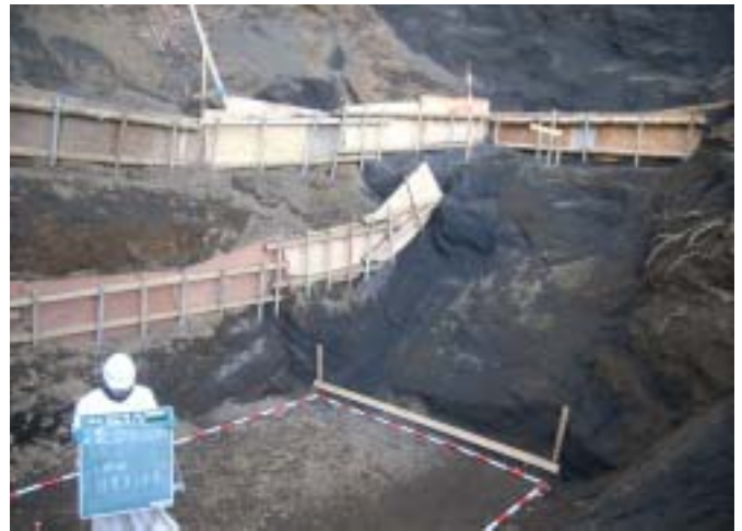
簡易土留柵 設置状況
