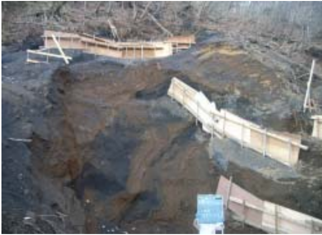
簡易土留柵 設置状況
