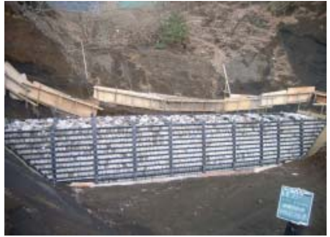
詰石(矢羽積)完了全景
