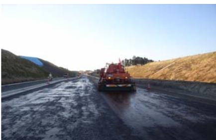
ディストロビューターによる瀝青材料散布状況
