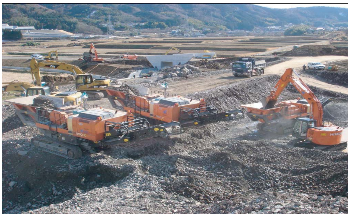
ガラパゴスによる岩砕破碎状況
