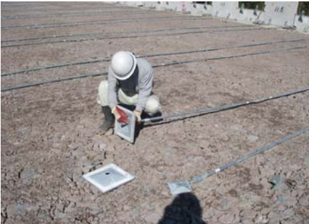
アンカープレート取付状況
