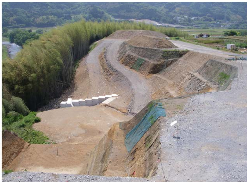
18年度 完成 及び 19年度 着工前
