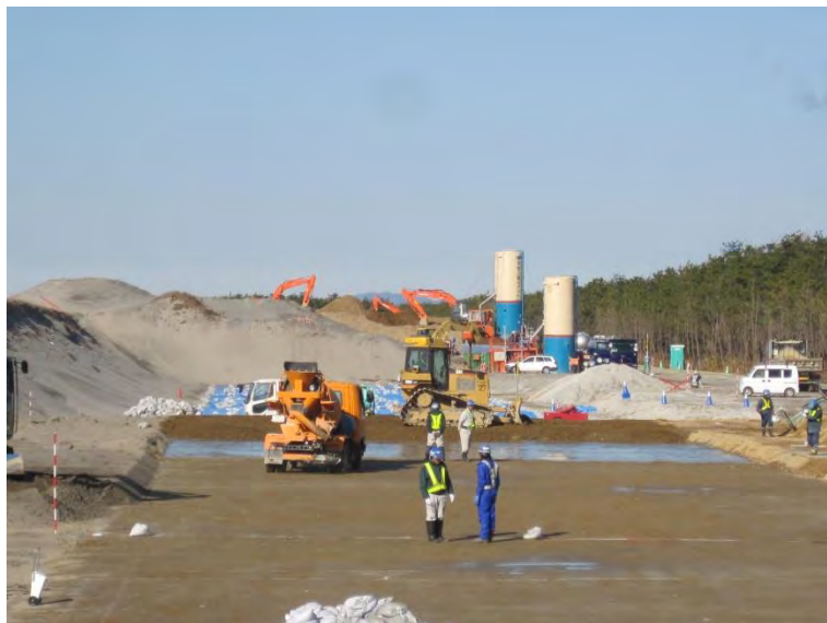
施工状況(全景)
