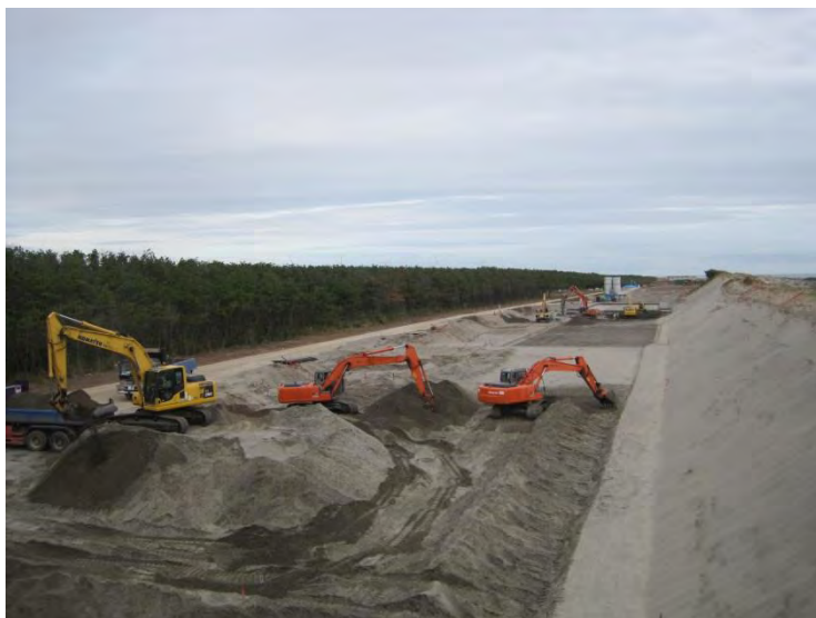
基礎掘削工
