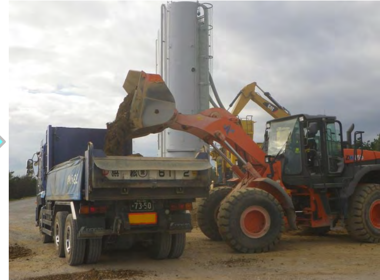
ダンプトラック積込・運搬
