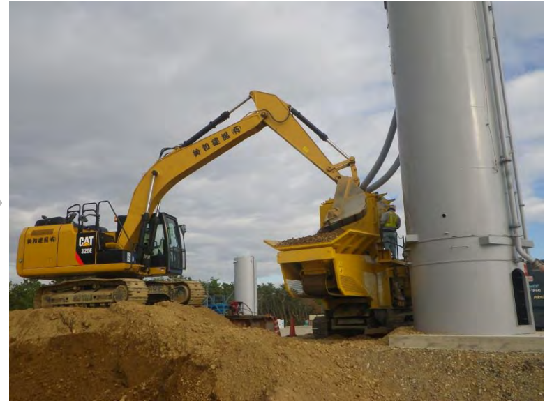
移動式混合機へ投入(CSG製造)
