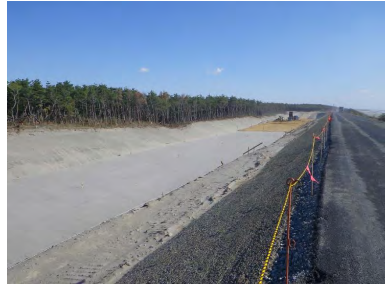
掘り下げ後の状況
