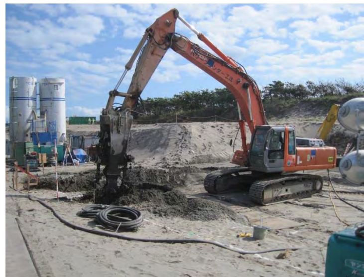
地盤改良工(近景)
