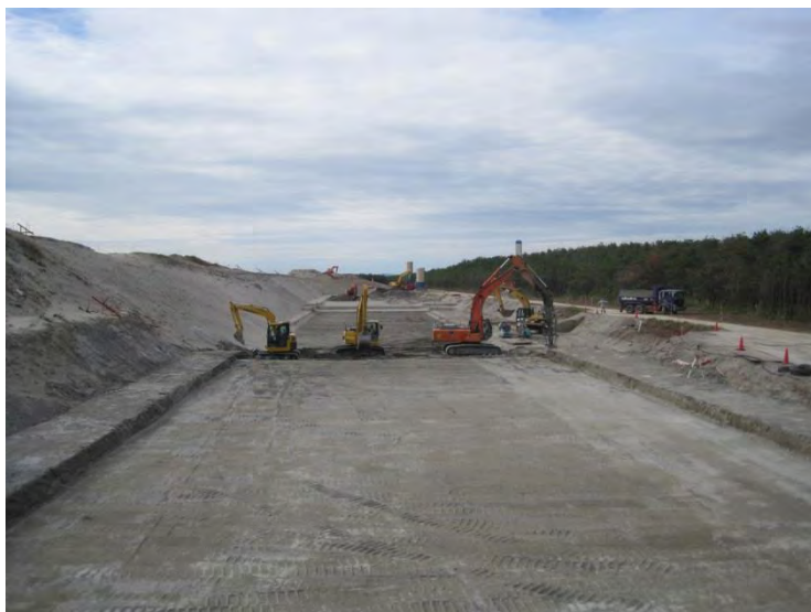
地盤改良工(遠景)
