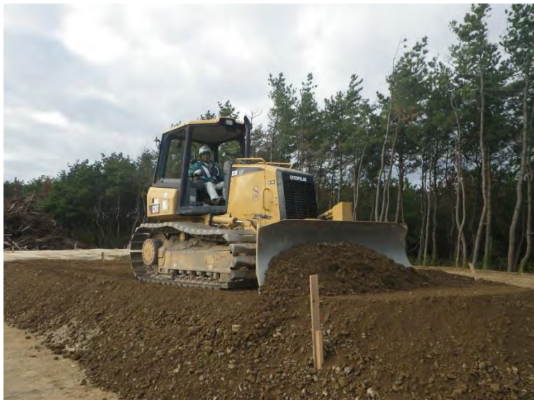
CSG敷均し(7t級ブルドーザー)
