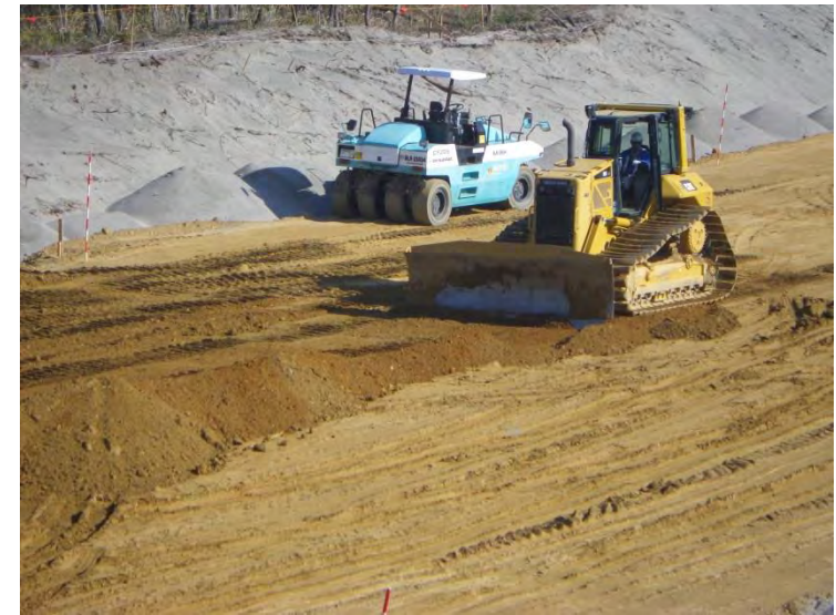
置換材の敷均し
