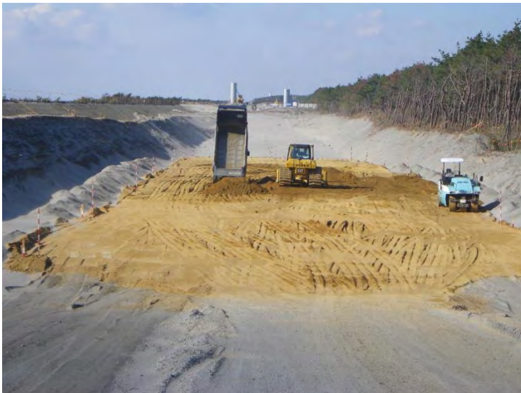
置換材の搬入
