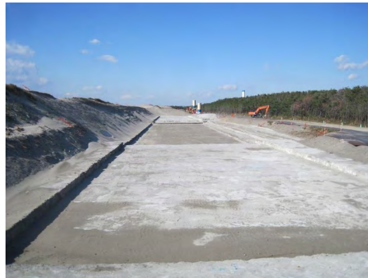
地盤改良工完了
