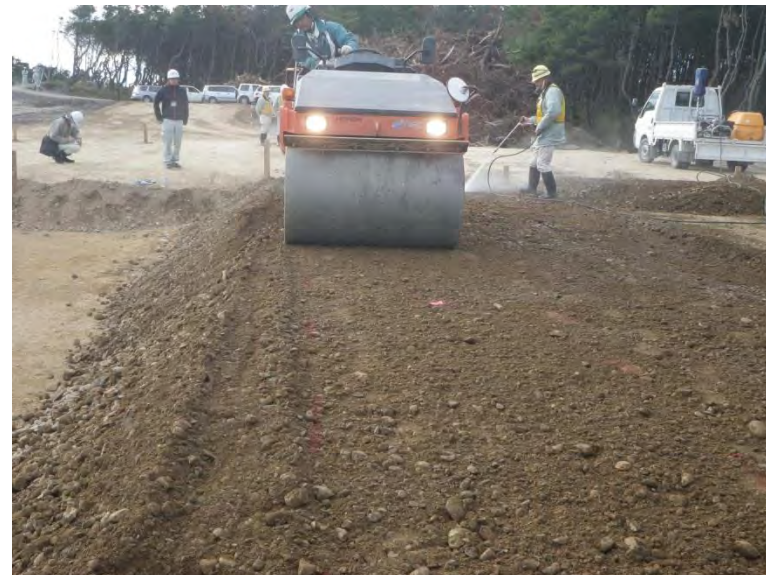
CSG転圧(4t級振動ローラー)
